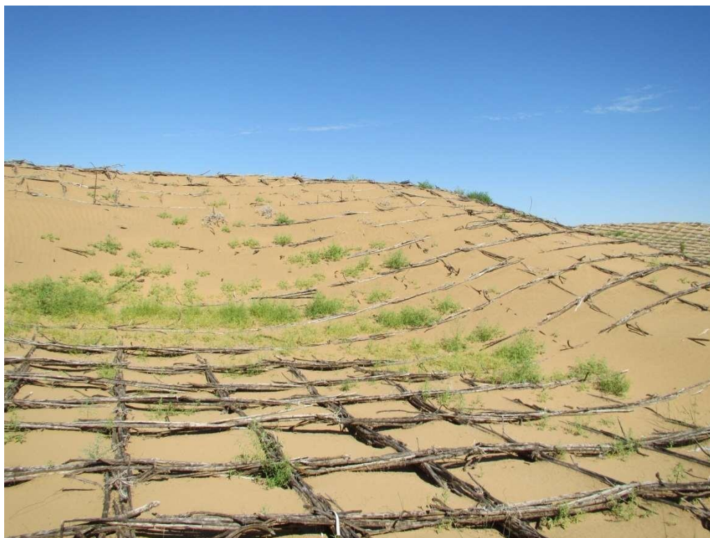
图 6.3-1 灌木阻沙沙障示意图
